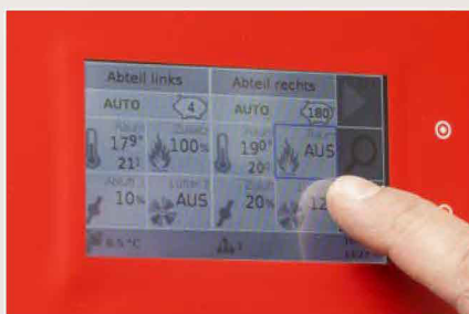
Die Anzeige am Touchbildschirm wechselt alle paar Sekunden zwischen Abteil 1+2 und 3+4. Neben den Stalltemperaturen zeigt das Display weitere Daten an, z. B. die Luftfrate, die Heizleistung oder Außentemperatur.
